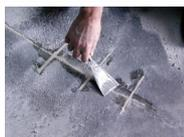
Zweikomponentiges, ungefülltes, schnell erhärtendes Polyesterharz (Topfzeit max. 15 Min.) zum kraftschlüssigen Festlegen und Verschließen von Rissen in Estrichen und Betonböden.
