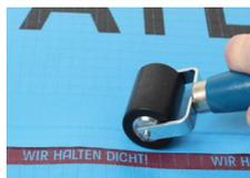
Diffusionsoffene Schalungsbahn für erhöht regensichere Unterdächer ab 2° Dachneigung bei Nahtverklebung mit Heißluft oder Quellschweißmittel.
